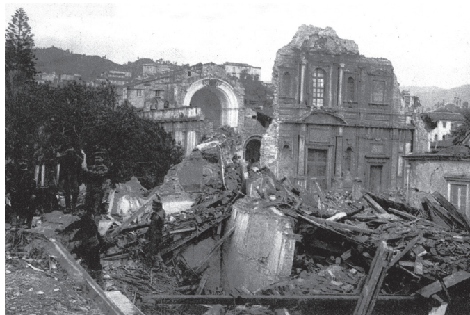
Разрушения в Мессине. (ЦВММ)
